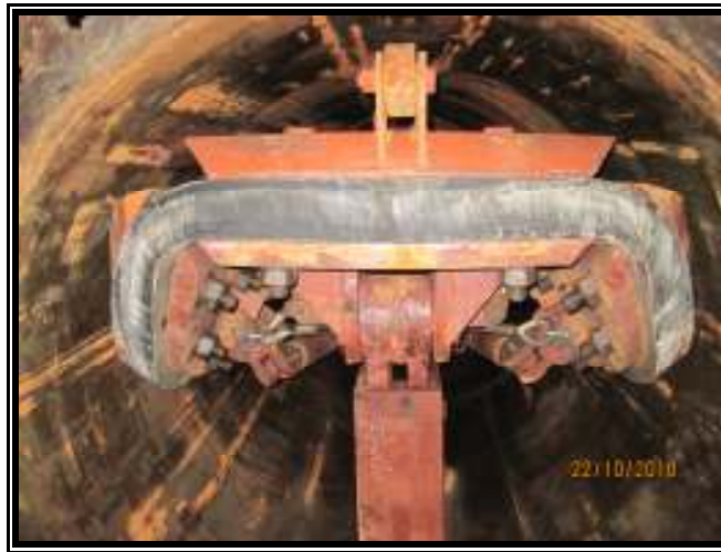
Rajah 25: Kedudukan stopper dalam mesin line stopping .
