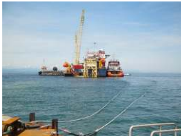
Rajah 10: Paip ditarik dari Pantai Labuan menggunakan tali dawai ( wire rope ).
