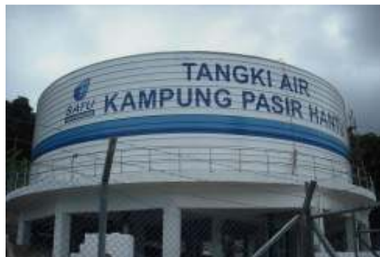
Rajah 6: 1.82JLH tangki air yang dibina di Pulau Perhentian Kecil.
