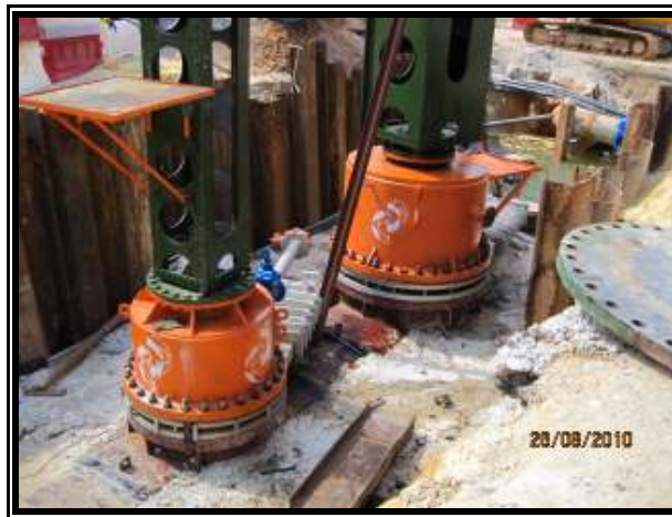
Rajah 27: Mesin hot tapping bersaiz 1000mm dan 1500mm yang telah siap di pasang pada paip sediaada di permukaan gate valve 1000mm.
