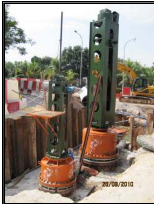
Rajah 26: Mesin line stopping yang telah siap dipasang pada paip sedia ada.
