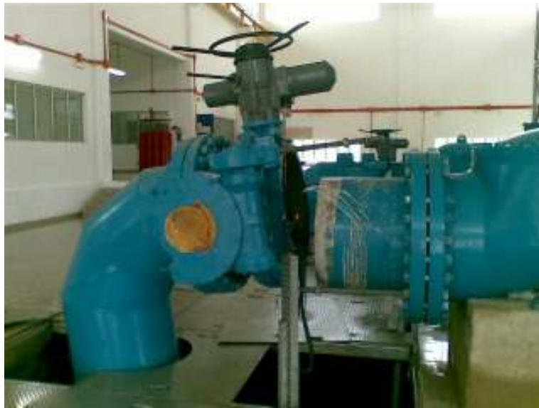
Rajah 17: Kegagalan pada flange adapter .
