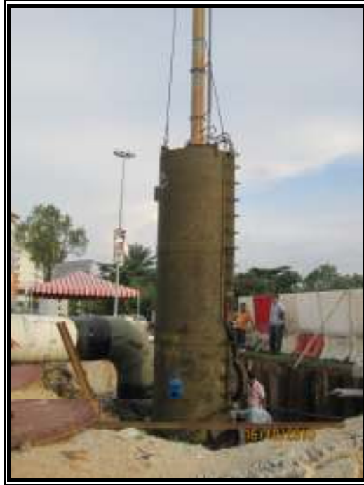
Rajah 24: Mesin line stopping yang siap dipasang di Jalan 17/1.
