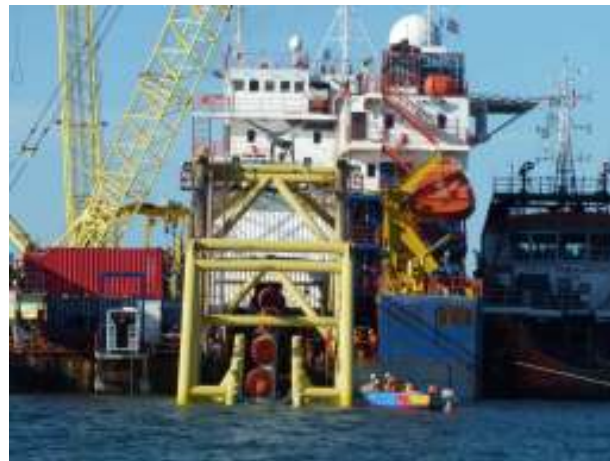
Rajah 12: Paip diturunkan ke dasar laut dengan bantuan air bags .
