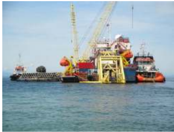
Rajah 11: Laybarge "STEALTH" digunakan untuk memasang paip dasar laut.
